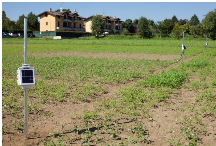
Pali in corrispondenza delle sonde per il rilievo dell'umidità e della temperatura del suolo
